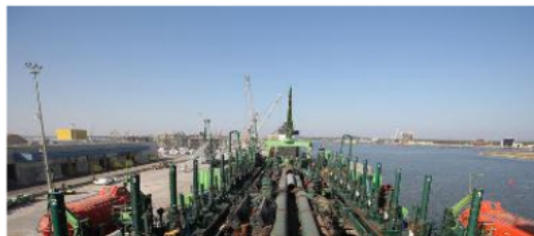
Il cantiere del progetto Hub portuale di Ravenna
